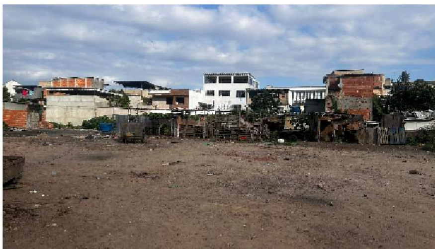
Figuras 08: Vista da parte posterior do terreno, próximo ao córrego Jacatirão, com diversas instalações irregulares. Fonte: Inepac.
