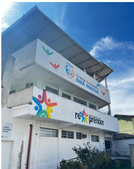
Figura 2 – Fotografia da Edificação em 2025
